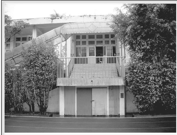
南棟大樓舊司令台2008年暑假拆除前模樣
